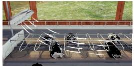
取り付けられたそれぞれのルーバーにより風は複数の層になって送り出され、淀むことなく牛舎内に空気の流れを作ります。 夏場は最大回転数で大きな風量を作り、 冬場には低回転で天井付近の温かい空気 を循環させます。
